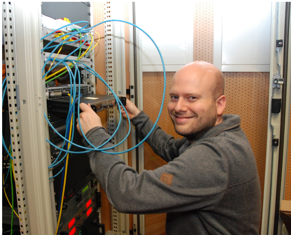
Rainer Bühl beim Einbau einer Funkstrecke im HS 14
